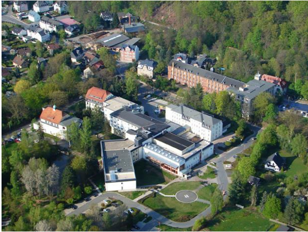
DRK Krankenhaus Lichtenstein: Weniger Energieverbrauch durch 30 neue Hochleistungspumpen Quelle: DRK Krankenhaus Lichtenstein 300dpi
