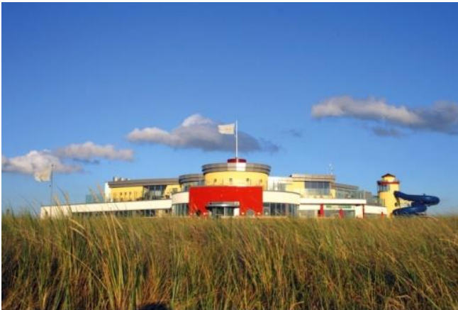
Das Gezeitenland - Borkums Wellness- und Erlebnisbad verbessert mit modernen Heizungsumwälzpumpen Energiebilanz und CO 2 -Ausstoß. Quelle: Nordseeheilbad Borkum GmbH
