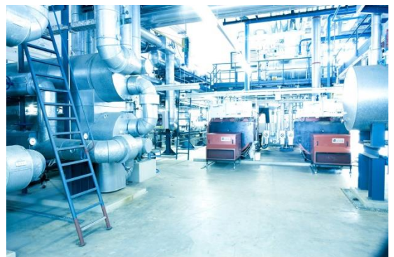
Der Pumpentausch konnte ohne Unterbrechung des laufenden Betriebes vorgenommen werden. Quelle: Christian Buck
