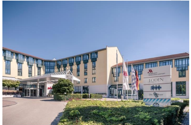
Das München Airport Marriott Hotel setzt auf den neusten Stand der Technik Quelle: München Airport Marriott Hotel
