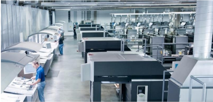
Neue hocheffiziente Pumpen sorgen für eine optimale Kühlung der Druckanlagen bei Aumüller. Quelle: Aumüller Druck GmbH
