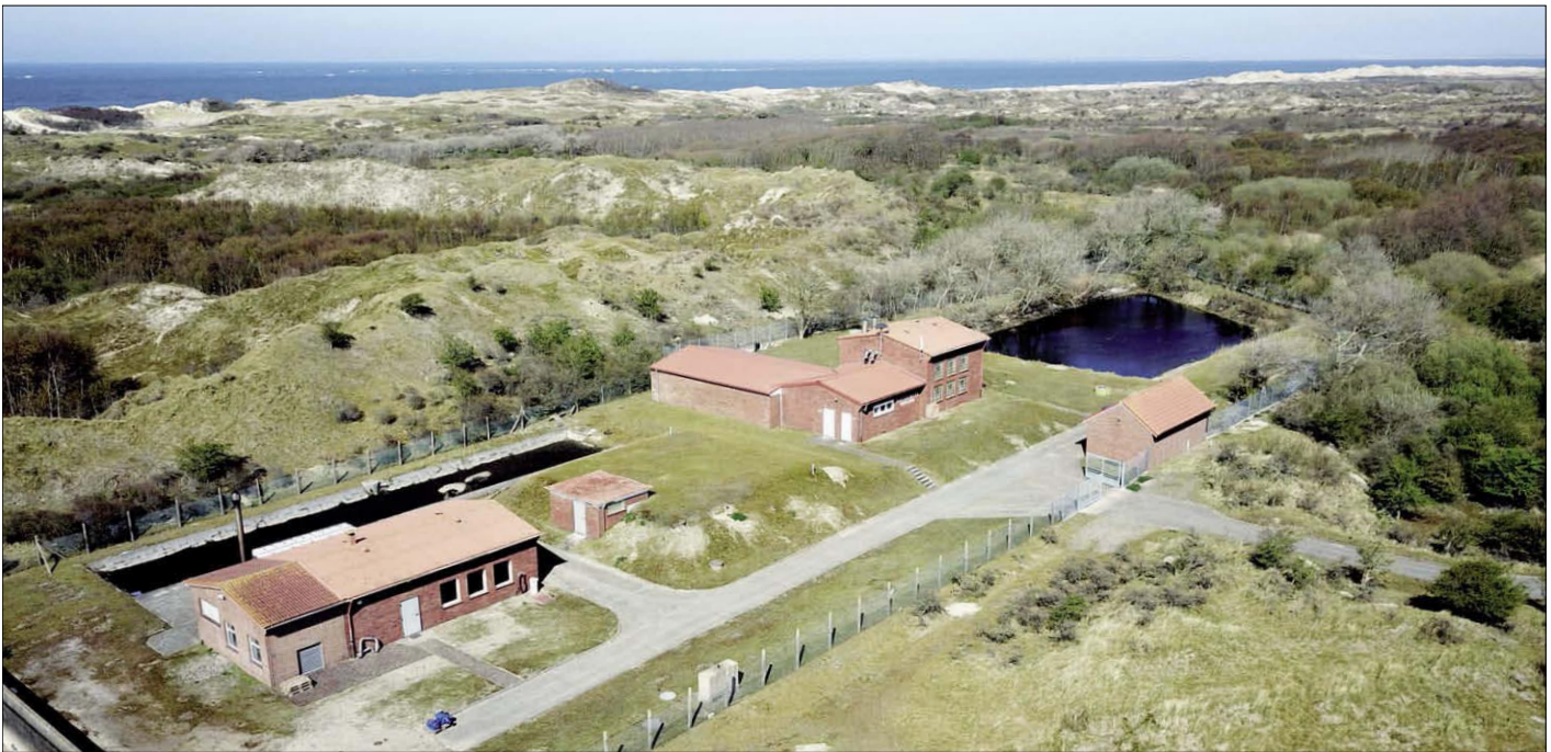
Im Wasserwerk von Borkum (Ostland) wurden drei Pumpen und eine Pumpensteuerung getauscht.
