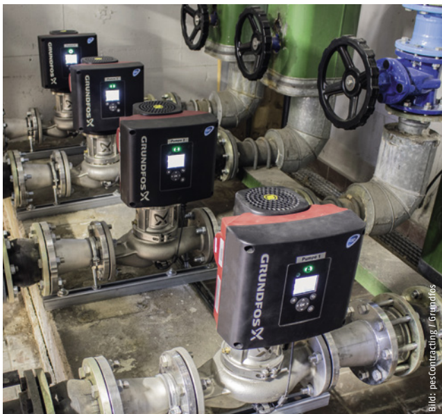
Laut Hersteller effizient und zuverlässig: Warmwasserzirkulationspumpen des Typs „TPE3“ von Grundfos.
